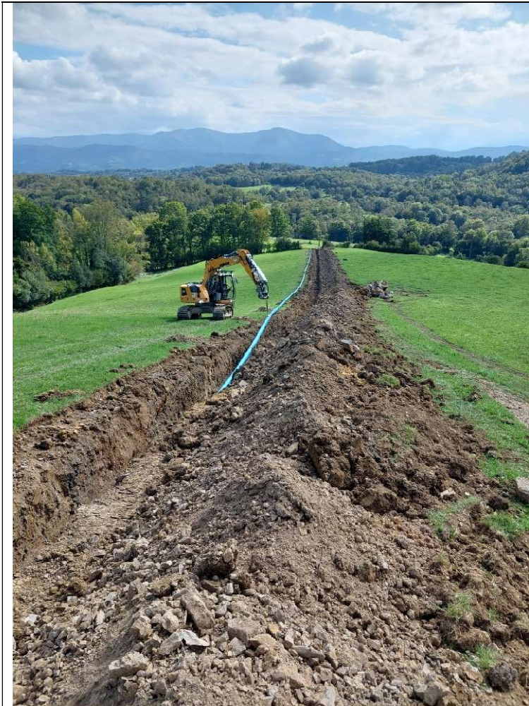
Renouvellement de réseaux d’eau potable Secteur Montesquieu Avantès – Réseau adduction Haute pression Acier
