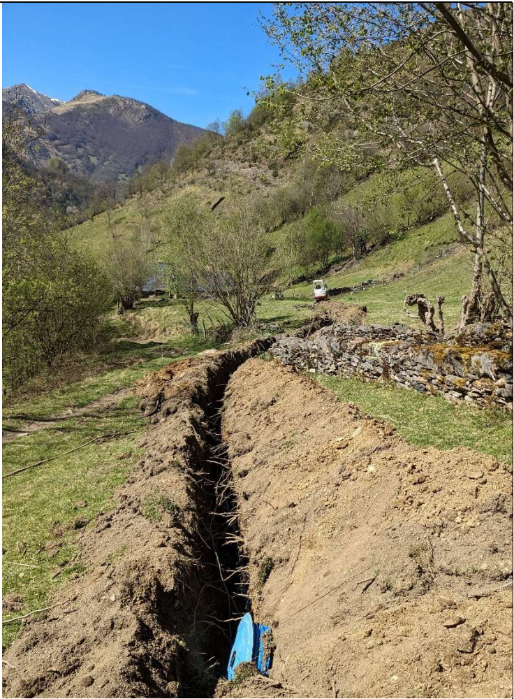
Renouvellement de réseau d’eau potable sur le secteur Laspe à Sentein
