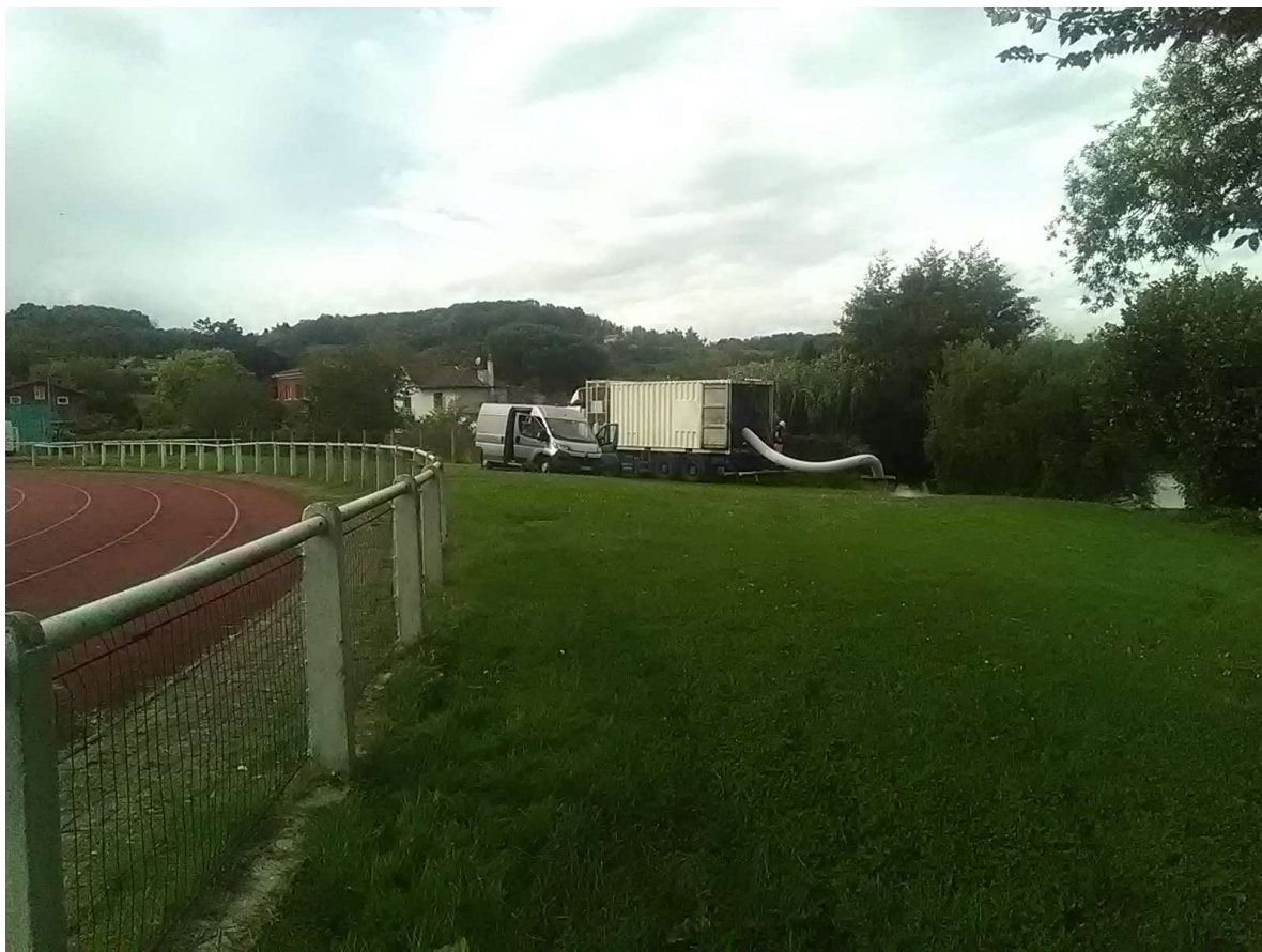
Chemisage du réseau rive gauche du Salat sur Saint Giron
