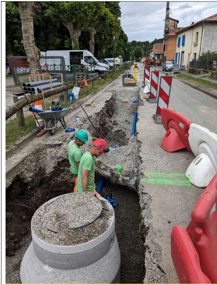
Création du réseau d'assainissement sur Bonrepaux
