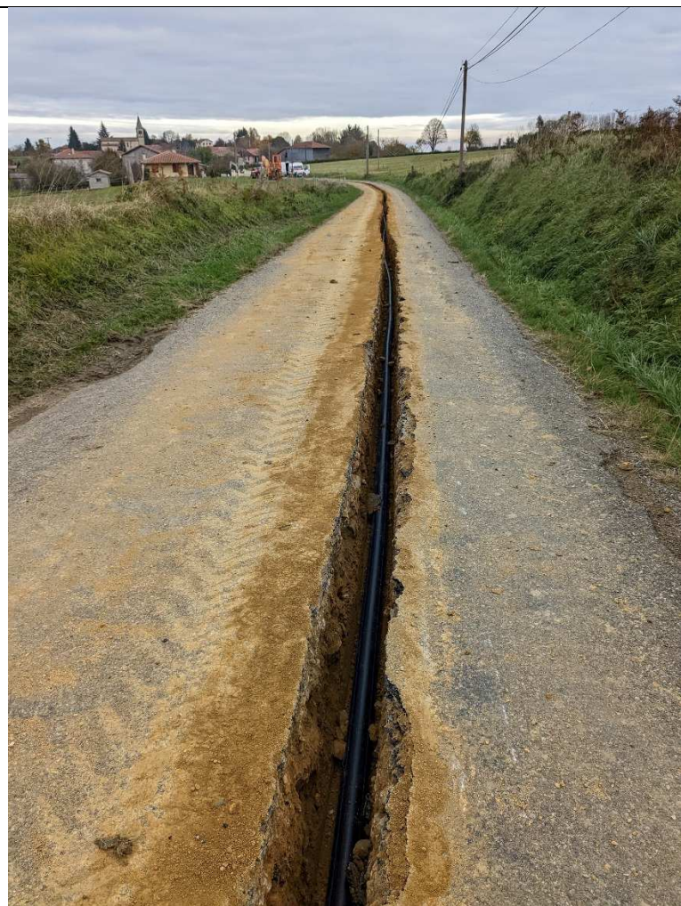
Renouvellement de réseaux d'eau potable Secteur La Cruzette à Lasserre
