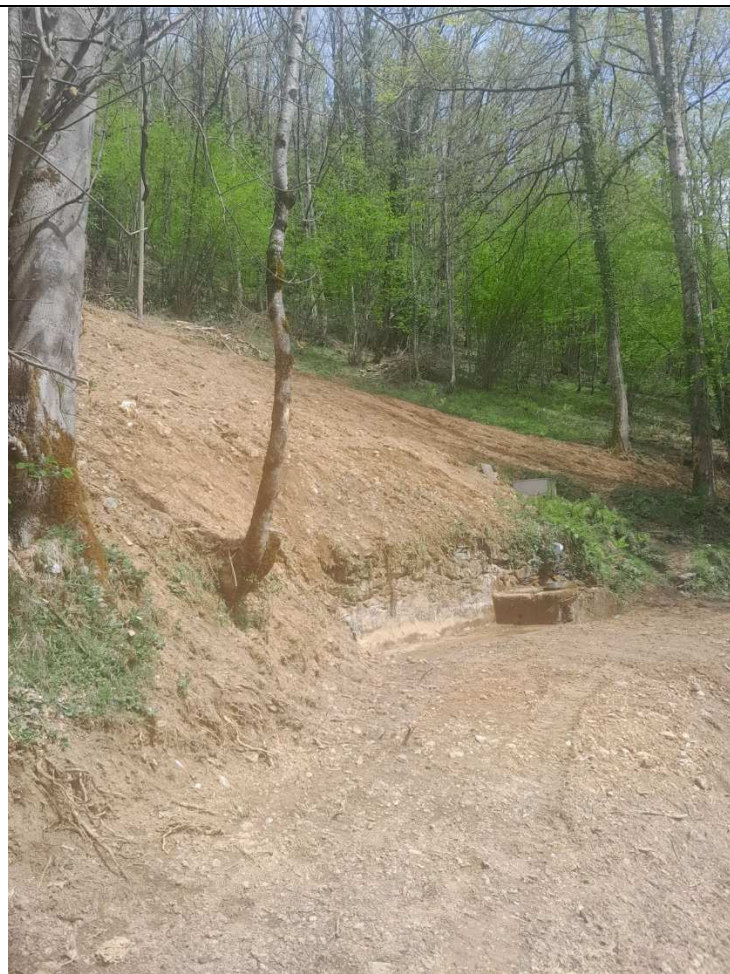
Réhabilitation du captage de Falat à Massat
