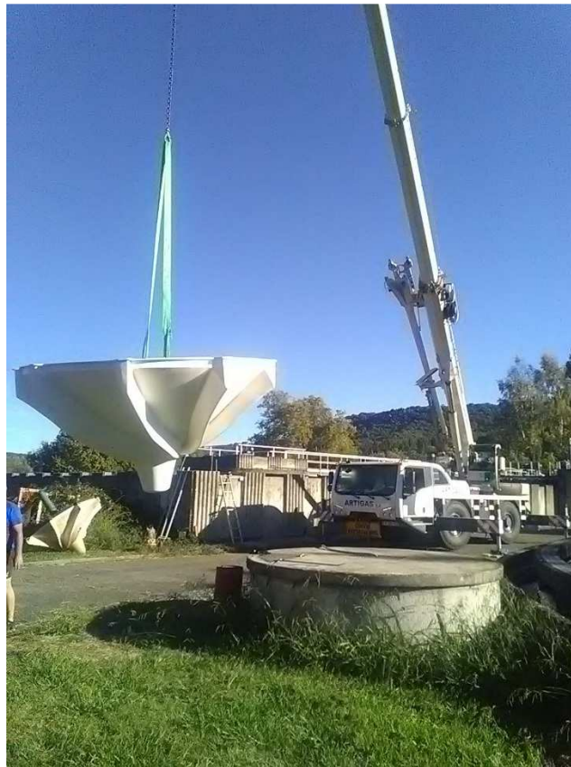
Remplacement de la turbine n°3 sur la station de Saint Lizier
