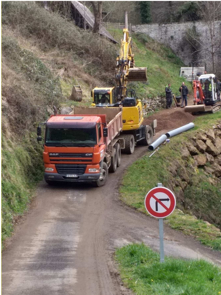
Pose de réseau d'assainissement sur Bethmale
