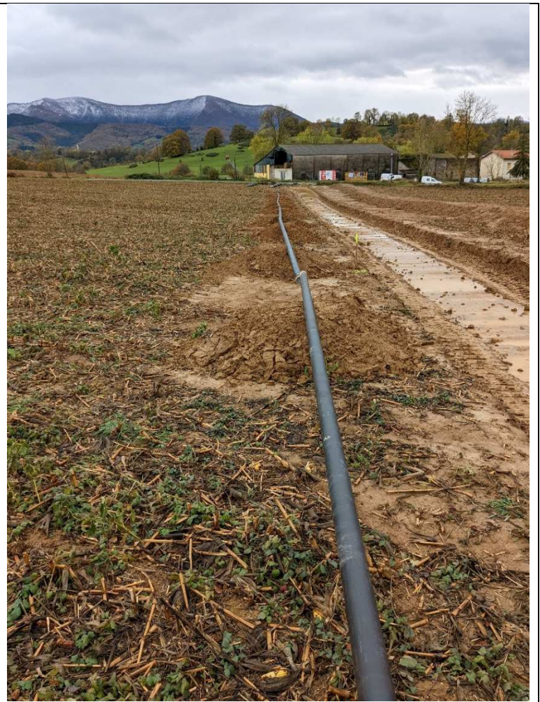
Renouvellement de réseau adduction haute pression sur Lescure
