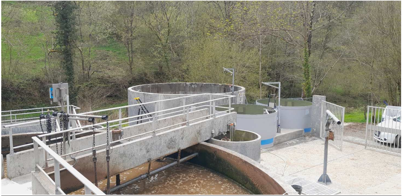
Modernisation de la station de Bethmale
